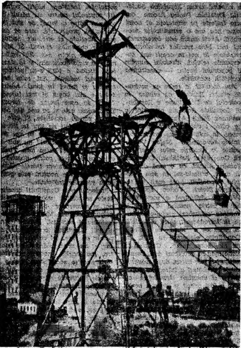
LONEA. Complexul de centralizare a producției minei se oglindește în densitatea de oțel a noului funicular de șist și în silueta avântă a turnului de beton al puțului cu schip. Asemenea lucrări se fac și la alte exploatarea miniere din Valea Jiului; 2,5 miliarde lei vor fi investiți în efortul viitor pentru deschiderea de noi mine și dezvoltarea celor existente.
