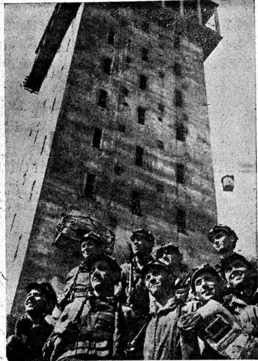
Lăcăușii montatori din brigada lui Wiesenmaier Ervin, sînt pe terminate cu montajele în casa de mașini și turnul pufului Lonea II, Iată-l într-o clipă de răgaz.
