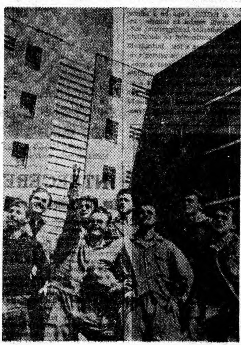
Blăcuștii din cartierul Livezeni se înalță semei spre vârfurile albastre. La construirea lor au contribuit și tinerii din brigada de zidărie condusă de Teodor Ioan. Zidul de lucru s-a terminat. Tinerii din brigadă au pornit în grup. Timpul liber și-l petrec tot împreună plăcut și instructiv.
