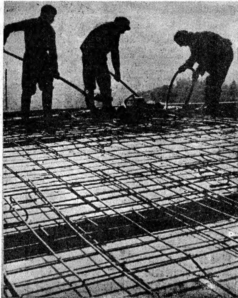
Se toarnă betonul.
