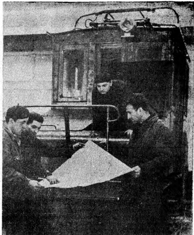
Echipa de lăcătuși condusă de Fănuș Ioan de la U.R.U.M.P. execută repararea unei locomotive electrice de 100 C.P. pentru mina Lonea.
