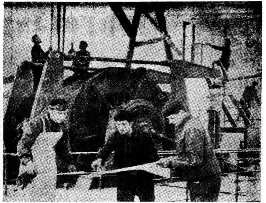
În acest an, la mina Aninoasa urmează să se încheie importante lucrări de concentrare și centralizare a producției la complexul situat în partea sudică a minei.
