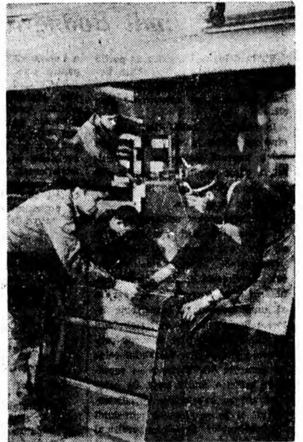
Echipa de lăcătuși-mecanici condusă de comunistul Mahasz Irimie de la Preparatia Coroști, este apreciată de întregul colectiv pentru lucrările de bună calitate pe care le execută. IN CLISEU: Echipa lucrînd la montarea unor ciururi la linia a II-a de spălare din preparatie.
