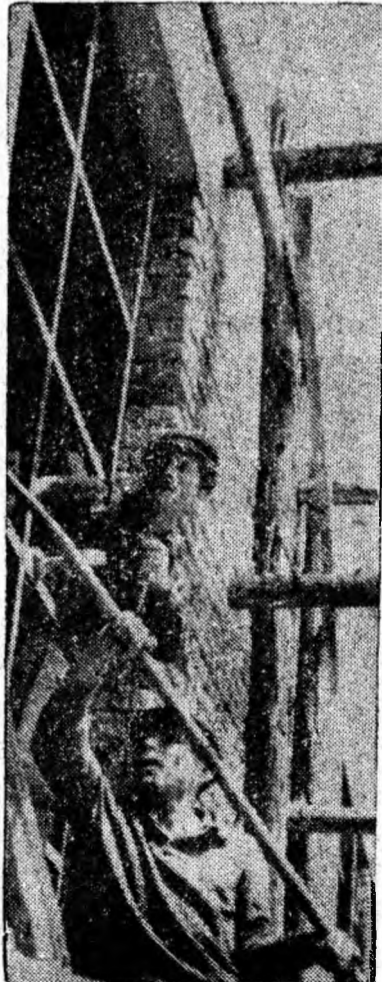
Se montează ferestrele metalice la atelierul electromecanic de la mina Dilja. Aici lucrează și echipa lui Chițu Ion.
