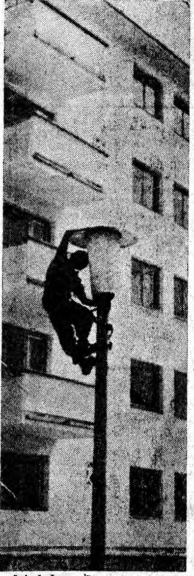
Sub balcoanele noului bloc se instalează lămpădarul cu neon.
