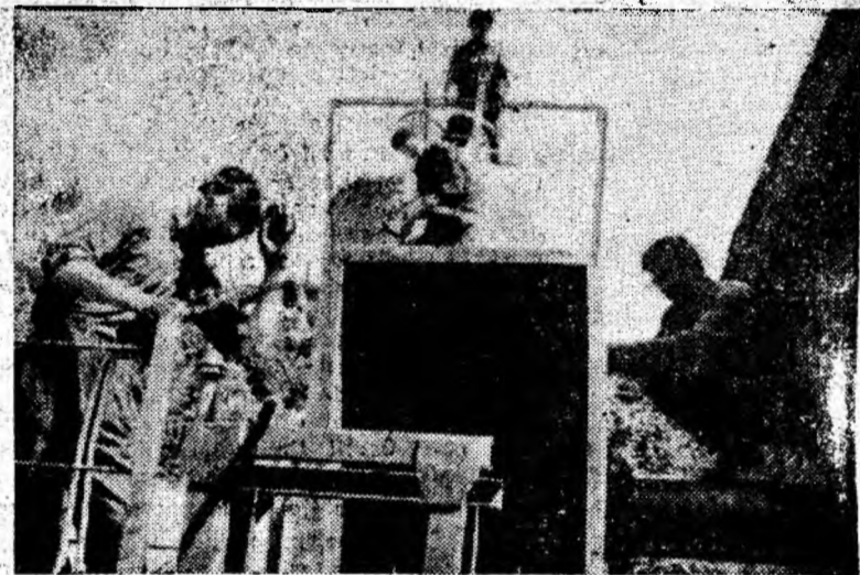
Tineretea e activă la toate începuturile mari. Patru tineri — sudorul Matei Gheorghe și lăcătușii Costea Ioan, Zoltan Vasile și Lambu Ilie de la T.C.M.M. — lucrează la montarea recipientului pentru aer comprimat la noua mină Bărbănteni.
