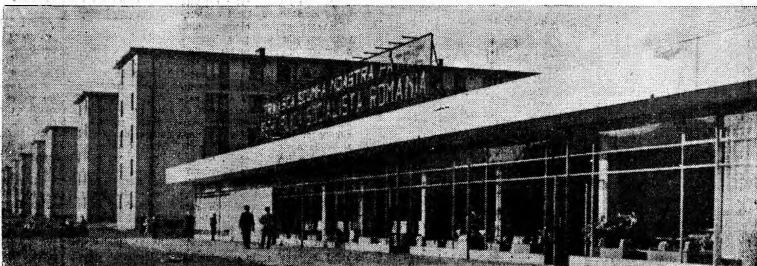
Pentru satisfacerea necesităților de aprovizionare a populației, în cartierul nou de blocuri Livezeni — Petroșani a fost construit un frumos complex comercial cuprinzînd 9 unități diferite. Anul acesta, complexul se dezvoltă prin construirea unei noi aripi cu o serie de unități diverse.
