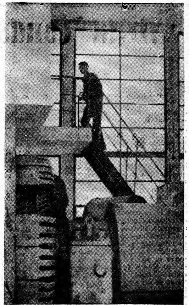
Instantaneu fotografic din casa mașinii de extracție a puțului Aninoasa-sud.
