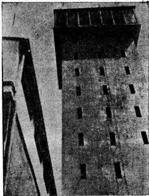
ÎNĂLȚIMI INDUSTRIALE. Silozul și impunătorul turn al puțului central cu skip de la mina Lonea II.
