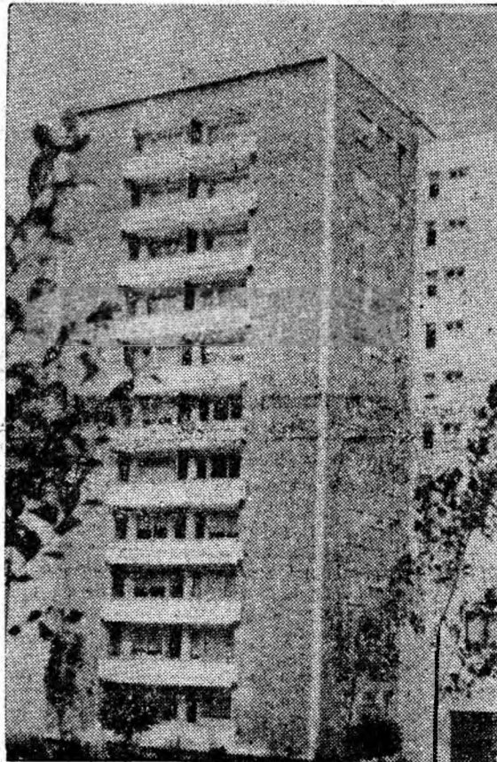
Unul din blocurile-turn înălțate de harnicii constructori în Lupeni.
