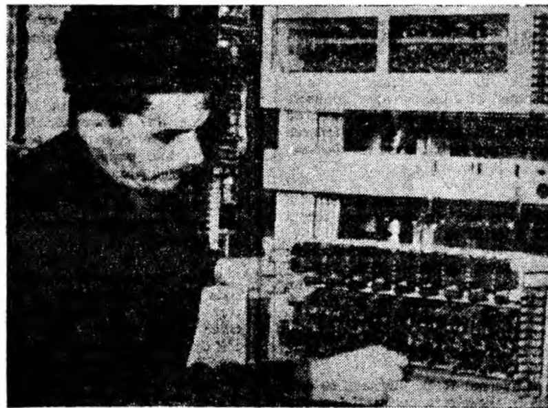
Maistrul electrician Popescu Emanoil de la sectorul T.T.R. Petroșani, executând montarea unui nou dispozitiv la noua centrală telefonică automată care se construiește în stația Petroșani.
