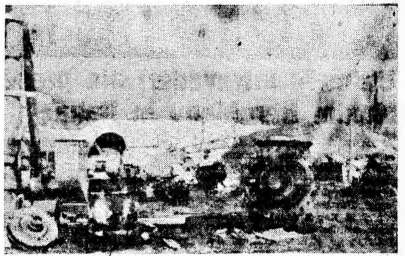
In mijlocul curții: ventilatoare, butoaie, roți de vagonete, tuburi de aeraj.
