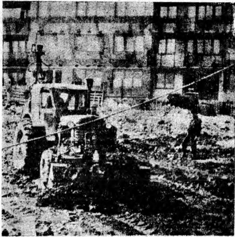
Lupeni. În fața noilor blocuri se nivelează terenul pe care vor apărea în curînd drumuri și spații verzi.
