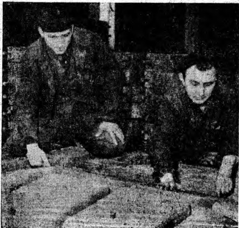
Xusu Tudor și Scurtu Gheorghe de la turnătoria de oțel a U.R.U.M. Petroșani, modelînd formele unor piese.
