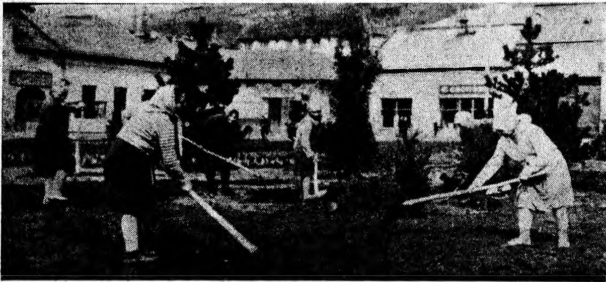
Lucrările de amenajare a scuarului din „Piața Victoriei” din Petroșani continuă.
