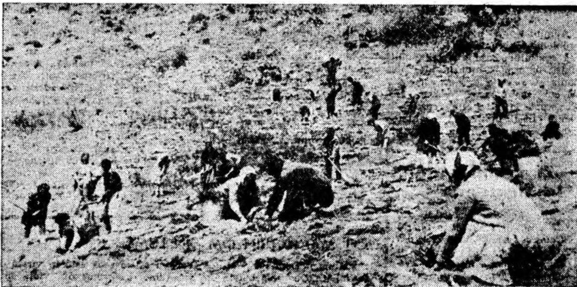
Șantierul de plantații de pe Maleia este cel mai mare șantier al Ocolului silvic Petroșani. Aici sub conducerea brigadierului Fondrea Virgil s-au plantat deja 70 hectare pe coastele văii. În puțin timp se vor termina și restul de lucrări, muncitorii înscriind la activul lor unul din succesele de seamă ale ocolului: plantarea într-o singură vale a 77 ha. teren masiv.
