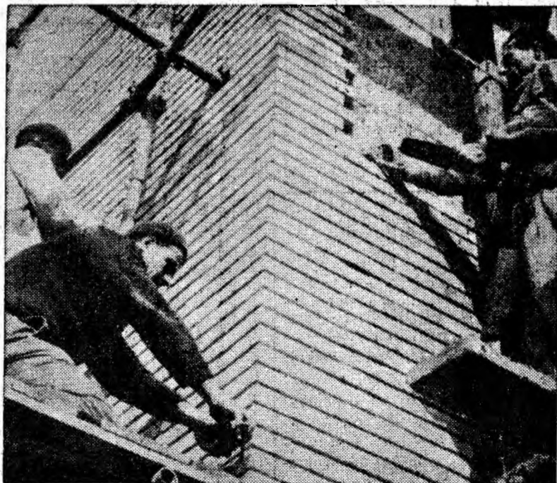
Zidarul Galigher Ștefan, șef de echipă, Cocian Stelian și Dună Marin lucrînd la placarea fațadei blocului C 3 b din microraioul B+C din Petroșani.
