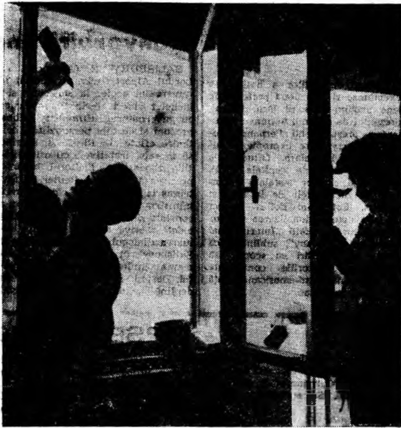
Sus pe înălțimi, zugravii Madaraș Iosif și Vișdea Viorel, atenți, desăvîrșesc capitolul finisare la liniile svelte ale blocului D 3 Petrila.
