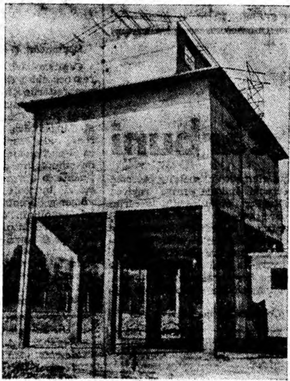
Noul siloz din incinta depozitului de materiale — Aninșasa sud
