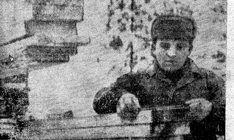
Galeria nr. 2 de la Lonea. Comunistul Pompei Stoica execută în mare măsură lucrări de calitate.
