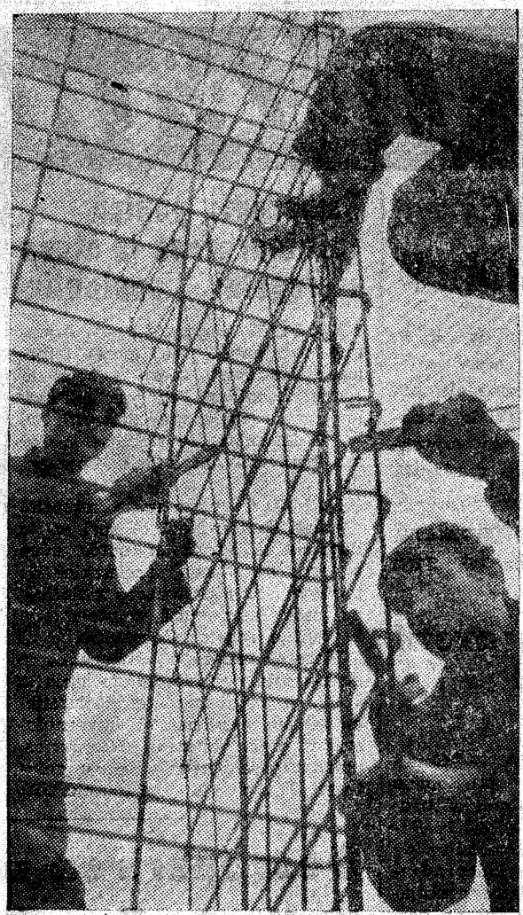
O parte din brigada de fierar-betonisti condusa de Alexandru Constantin de la santierul Lupeni al T.R.C.H. La multe din realitatile urbanistice ale orasului si-au adus o contributie substanțiala fierar-betonistii.
