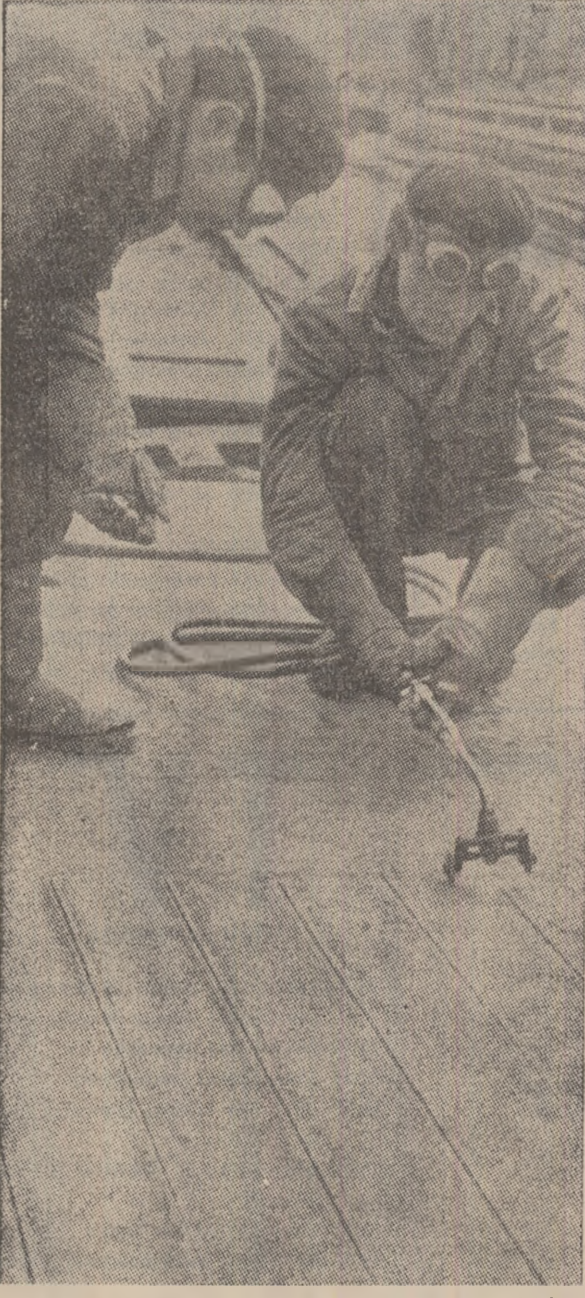
Atenție și pricepere. Sudorul autogen Carol Bărbuș împreună cu elevul din anul II de la grupul școlii profesionale Petroseni, Gărgăriș Dumitru, pregătesc materiale pentru construcțiile metalice ce se execută la U.R.U.M.P.
