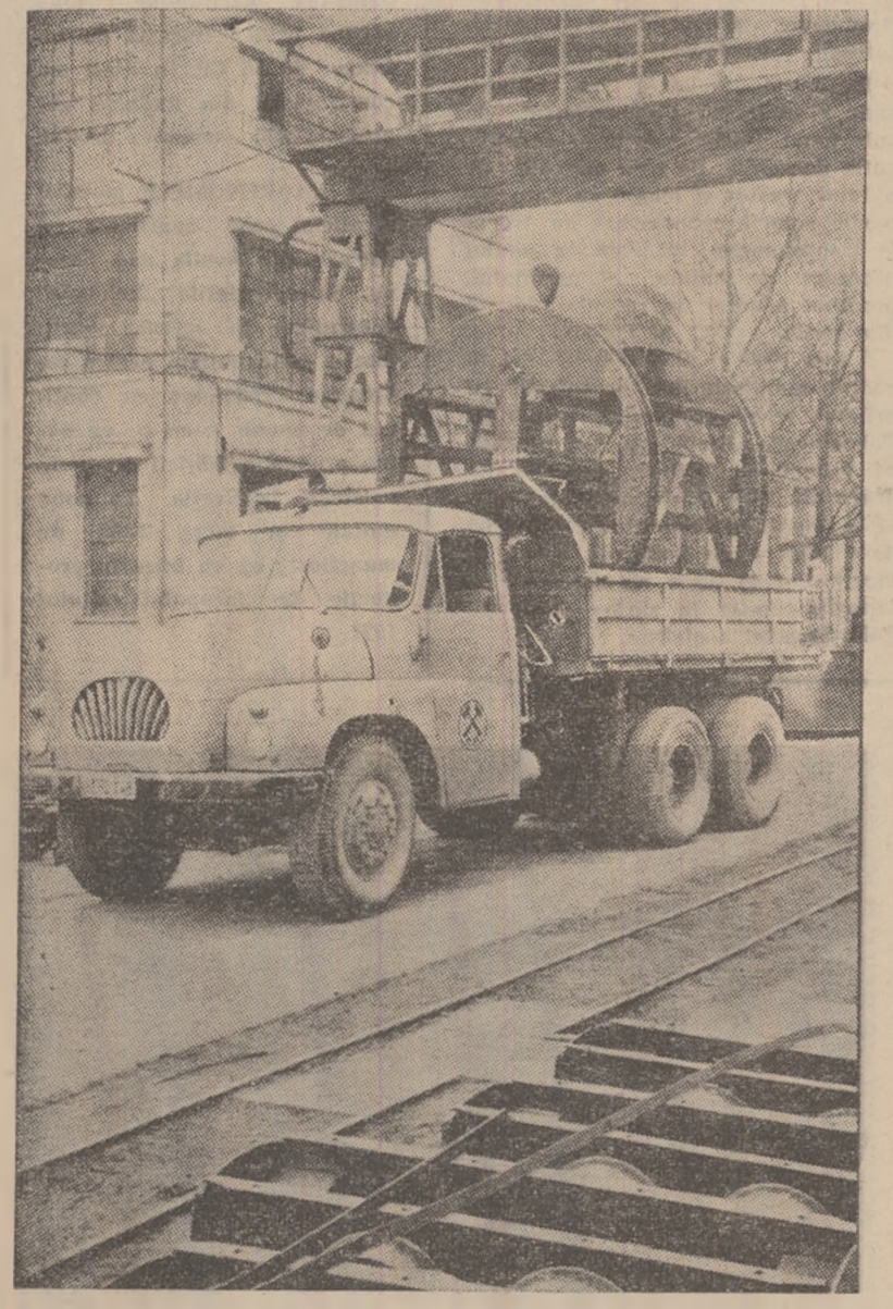
Zilnic, metalurgistii de la U.R.U.M.P. trimit la exploatarea minierii din Valea Jiului însemnate cantități de ulei și piese de schimb. ÎN CLISEU: Puternica macara poartă din curtea uzinei încărcă într-un autocamion un nou eschibul de mină.
