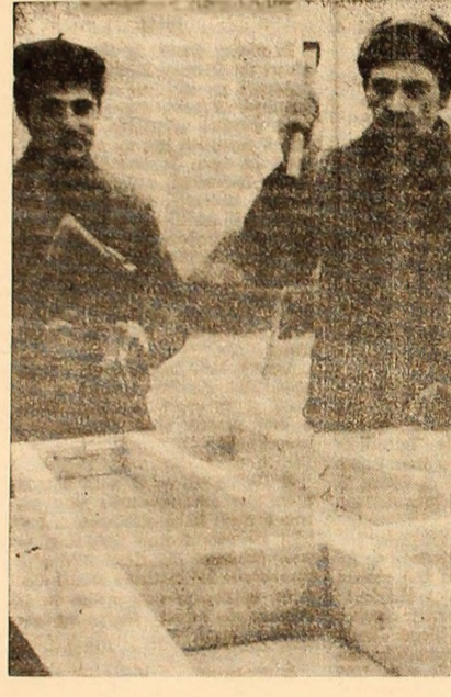
Recondiționarea cotrajelor nu este de loc o problemă minoră și de acest lucru s-au convins dulgerii Modăș Alexandru și Coar Nicolae de pe șantierul minei Iizeveni — în imagine.
