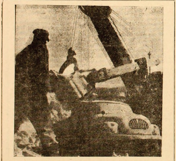
Încărcarea mecanizată a minereului de fier la E. M. Teliuc.
