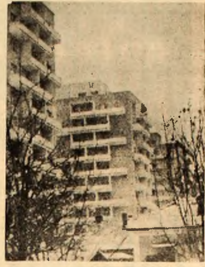
Pe strada Republicii din Petroșani, alături de vechile locuințe, au început să se înalțe blocuri moderne, cu 10 etaje și 66 apartamente, plătute cu plăcuțe ceramice: zilele trecute a fost predat cel mai nou bloc — B 1 e — al patrulea bloc ridicat în această parte a orașului nostru.
