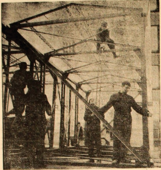
Intr-una din secțiile Uzinei de utilaj minier Petroșani: Harnicii lăcătuși din brigada lui Eugen Heintz montează scheletul metalic al culoarelor viitoare benzi de transportat cărbune.
