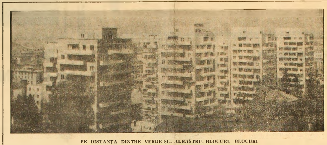
PE DISTANȚA DINTRE VERDE ȘI ALBASTRU, BLOCURI, BLOCURI
