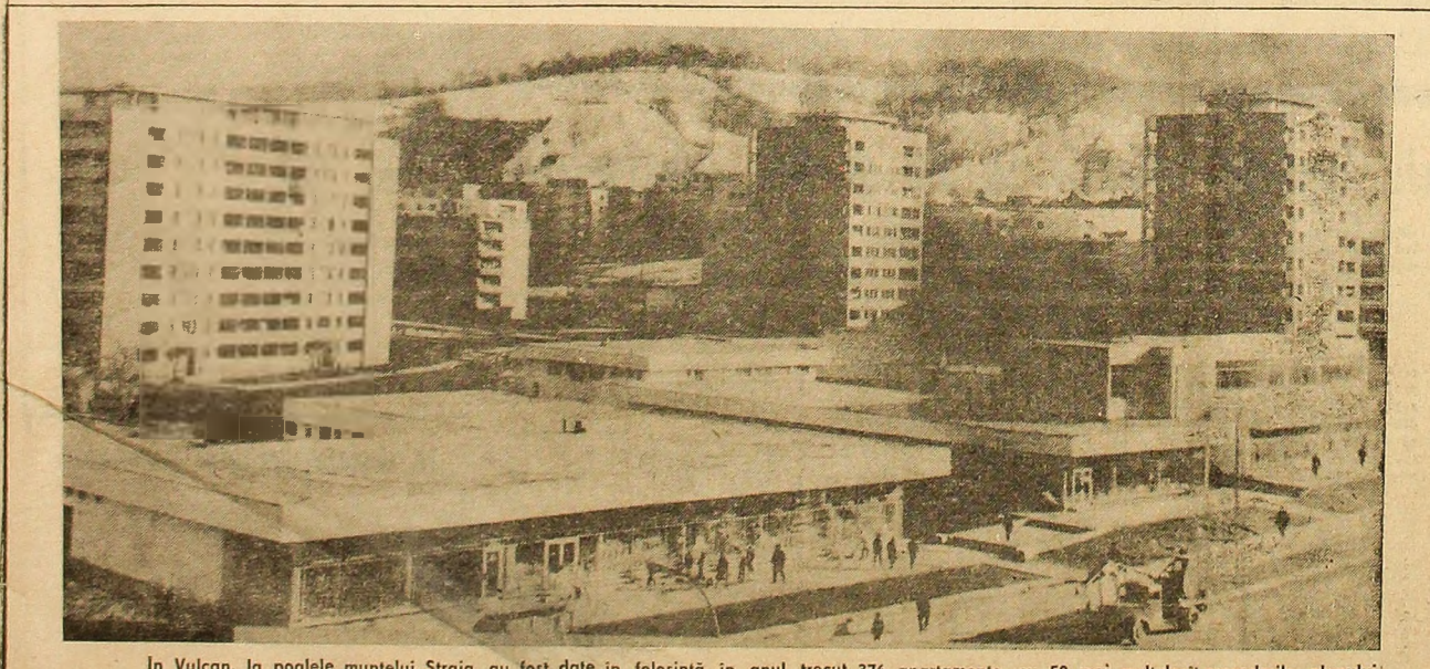
În Vulcan, la poalele muntelui Stroja, au fost date în folosință în anul trecut 376 apartamente, cu 50 mai mult decît prevederile planului, cit și un modern complex comercial. În foto: Vedere parțială a noului cartier vulcănean (în prim plan complexul comercial).
