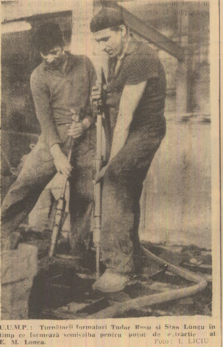
U.U.M.P.: Turnătorii farmatori Tudor Boș și Stan Lîngu în timp ce formează senisaba pentru puțul de extracție al E. M. Lonea. Foto: I. LICIU
