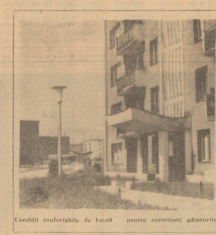
Condiții confortabile de locuit pentru cuceritorii adîncurilor
