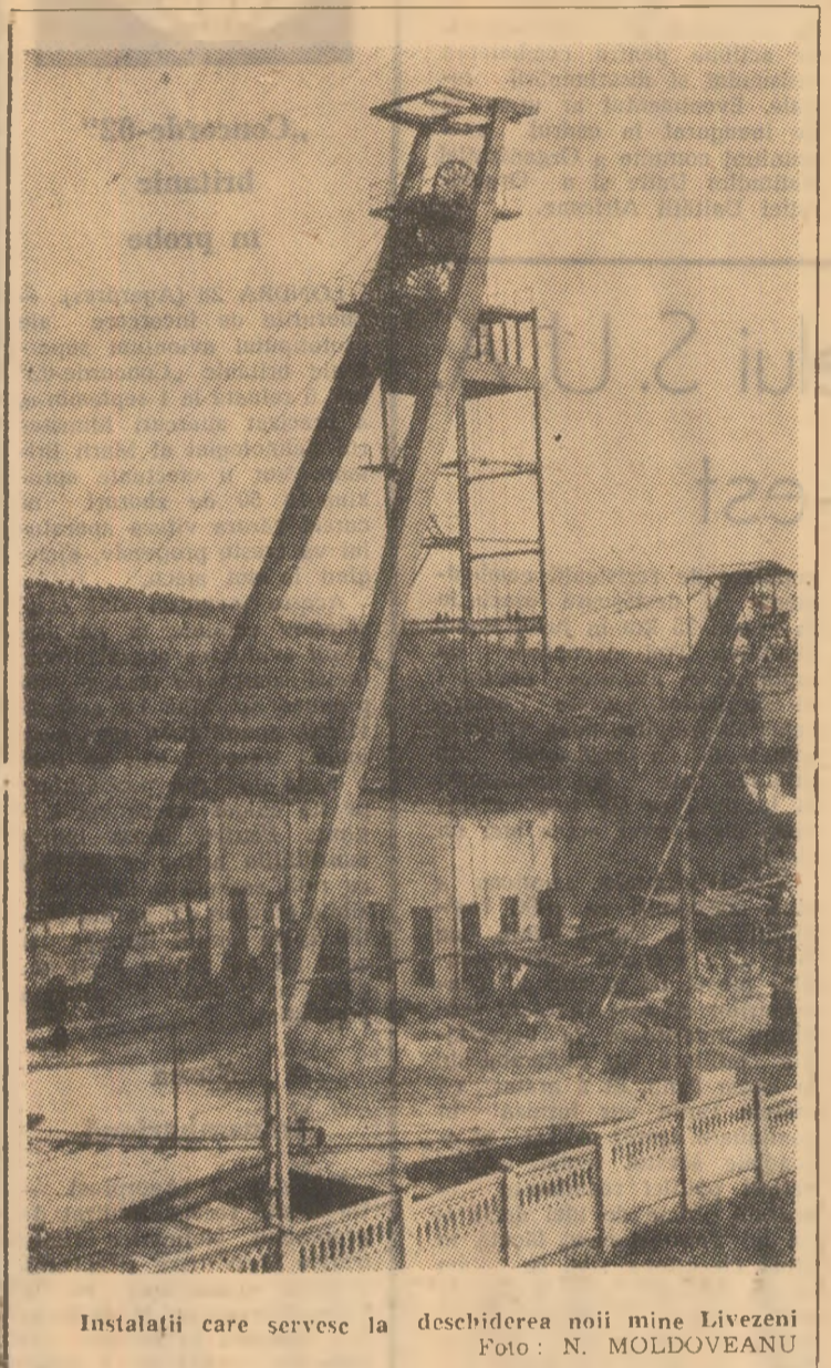
Instalații care servesc la deschiderea noii mine Livezeni. Foto: N. MOLDOVEANU
