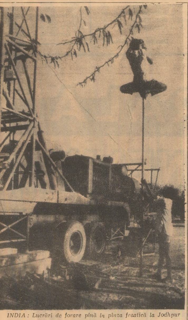
INDIA: Lucrări de forare pînă la pînza freatică la Jodhpur
