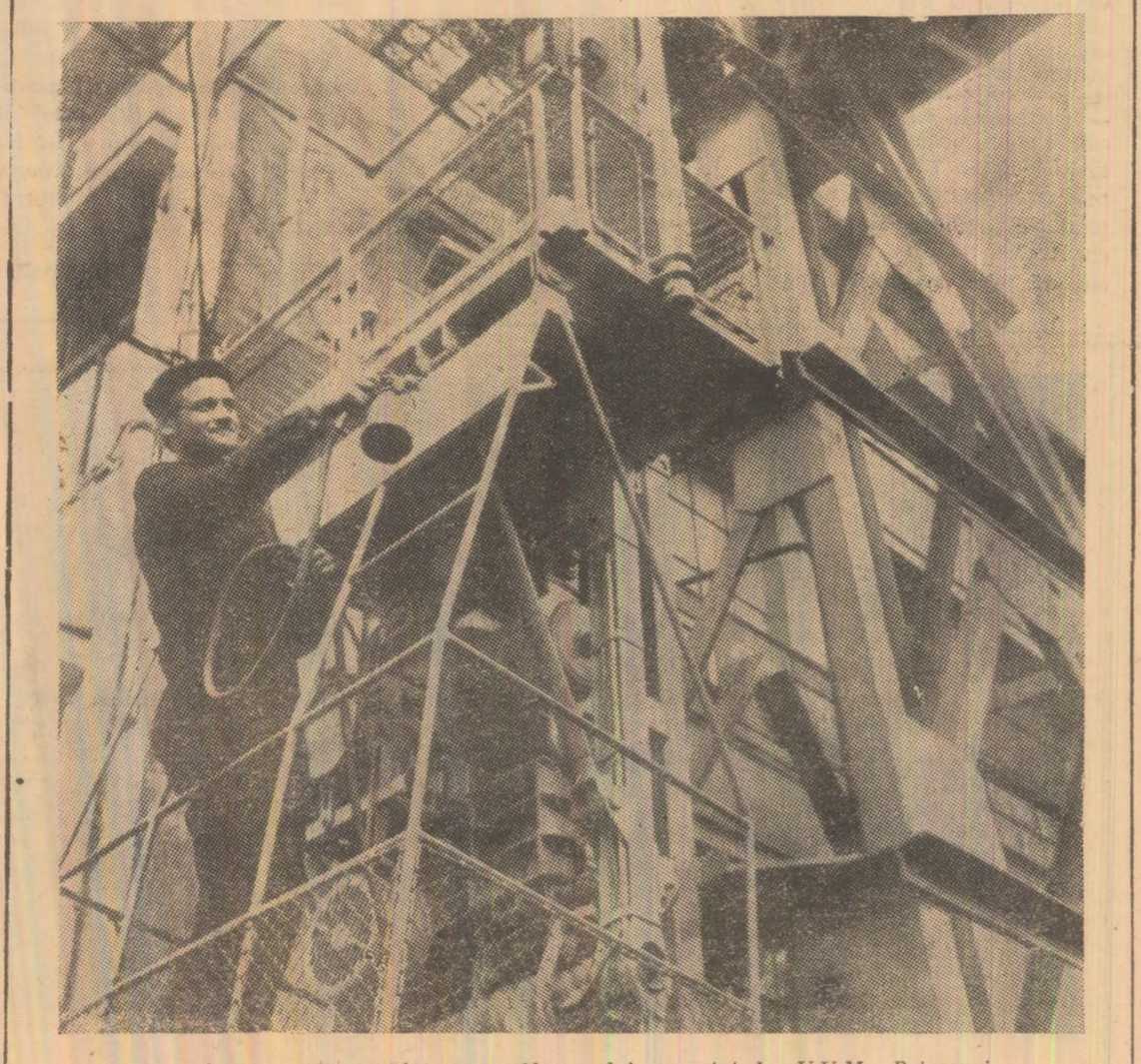
Ultima fază — de vopsire — a Alemaului executat la U.I.M. Petroșani
