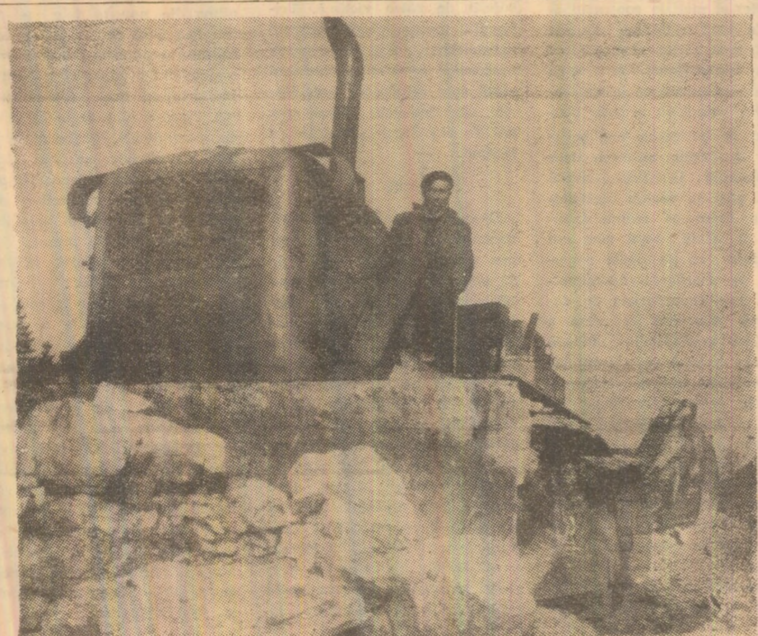
Buldozeristul Gheorghe Paraschiv — unul din oamenii de „bază” ai barajului de la Valea de Pești, dirijând piatra pe fundație. Foto: I. LICIU
