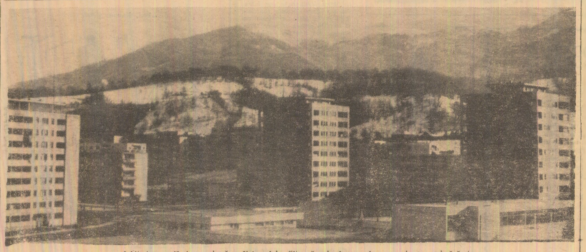
Arhitectura suplă și armonioasă a Vulcanului... filtrează primele raze de soare, zice-se... primăvăratec
