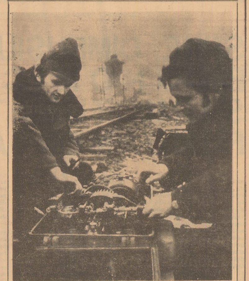
S-a ivit vreo defecțiune? Nu! Se face doar pe orice timp o revizie tehnică a macazului automat.
