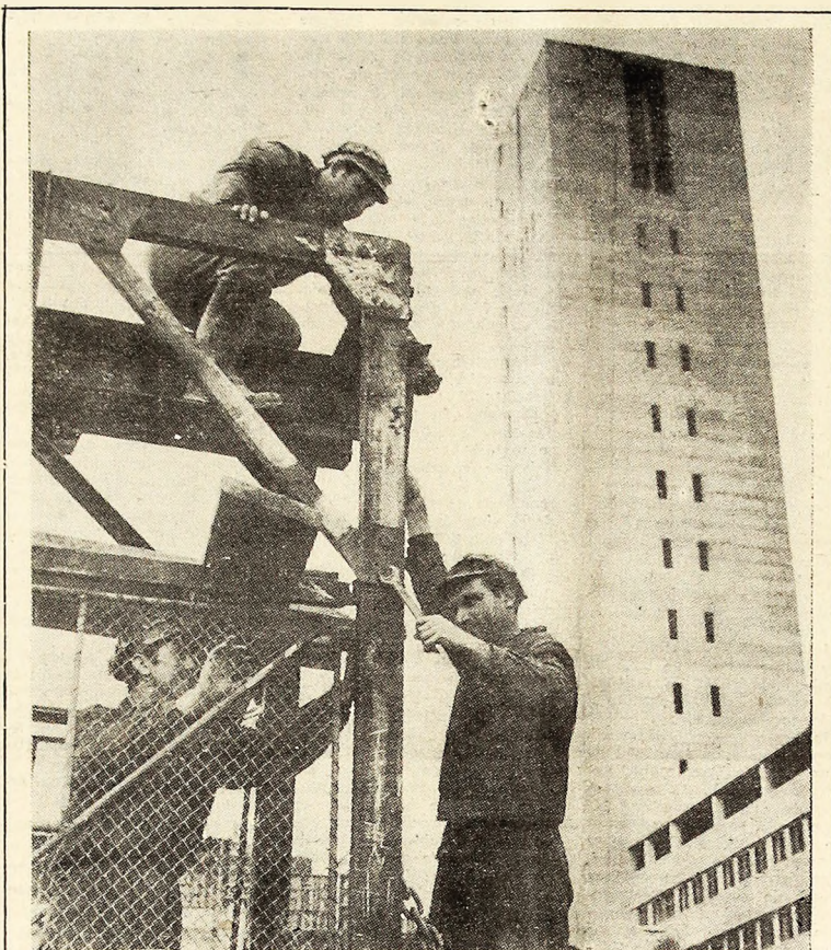
Ion Cioacă, Ion Bobeică și Silviu Ôtvôș din echipa de lăcătuși a E. M. Livezeni surprinși de obiectiv la montarea cuștii de amenajare a ghidajele metalice a puțului auxiliar.
