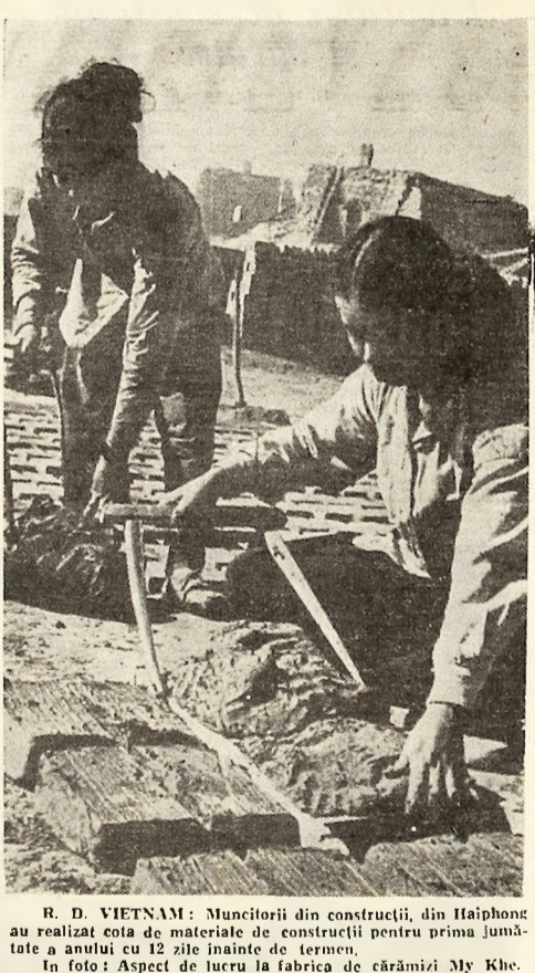
R. D. VIETNAM: Muncitorii din construcții, din Hai Phong au realizat tota de materiale de construcții pentru prima jumătate a anului cu 12 zile înainte de termen.
