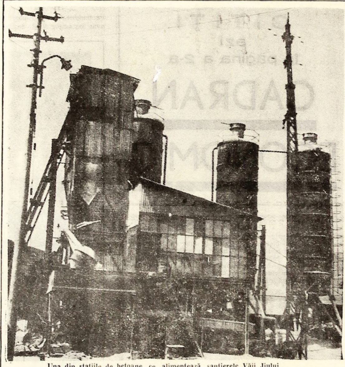
Una din stațiile de betoane ce alimentează șantierele Văii Jiului.
