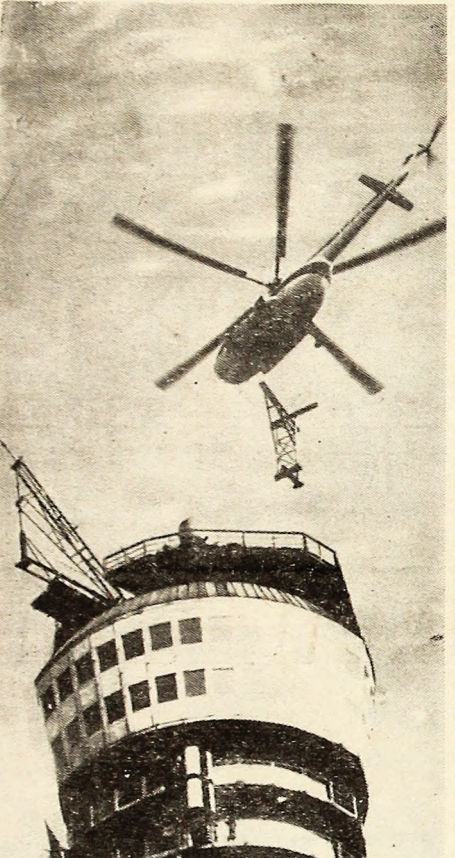
R. D. GERMANIA: Instalarea antenei pe noul turn de televiziune de la Schwain, la 110 m înălțime ar fi necesitat instalații speciale și mult timp. Cu ajutorul elicopterului însă, această operație a durat câteva ore. În foto: Montarea antenei pe turnul de televiziune, cu ajutorul elicopterului.
