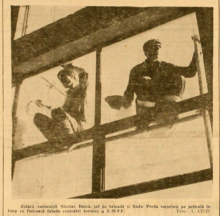
Zidarii comunisti Nicolae Duică, șef de brigadă și Radu Preda surprinși pe pelnicul în timp ce finisează fațada centralei termice a U.M.T.F. Foto: I. LICIU
