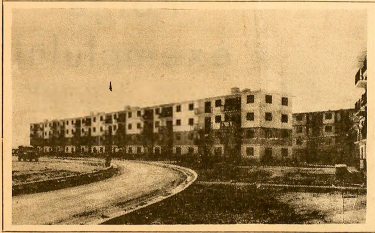
REPUBLICA CUBA: În foto: Un nou cartier de locuințe, în construcție în provincia Camaguey.
