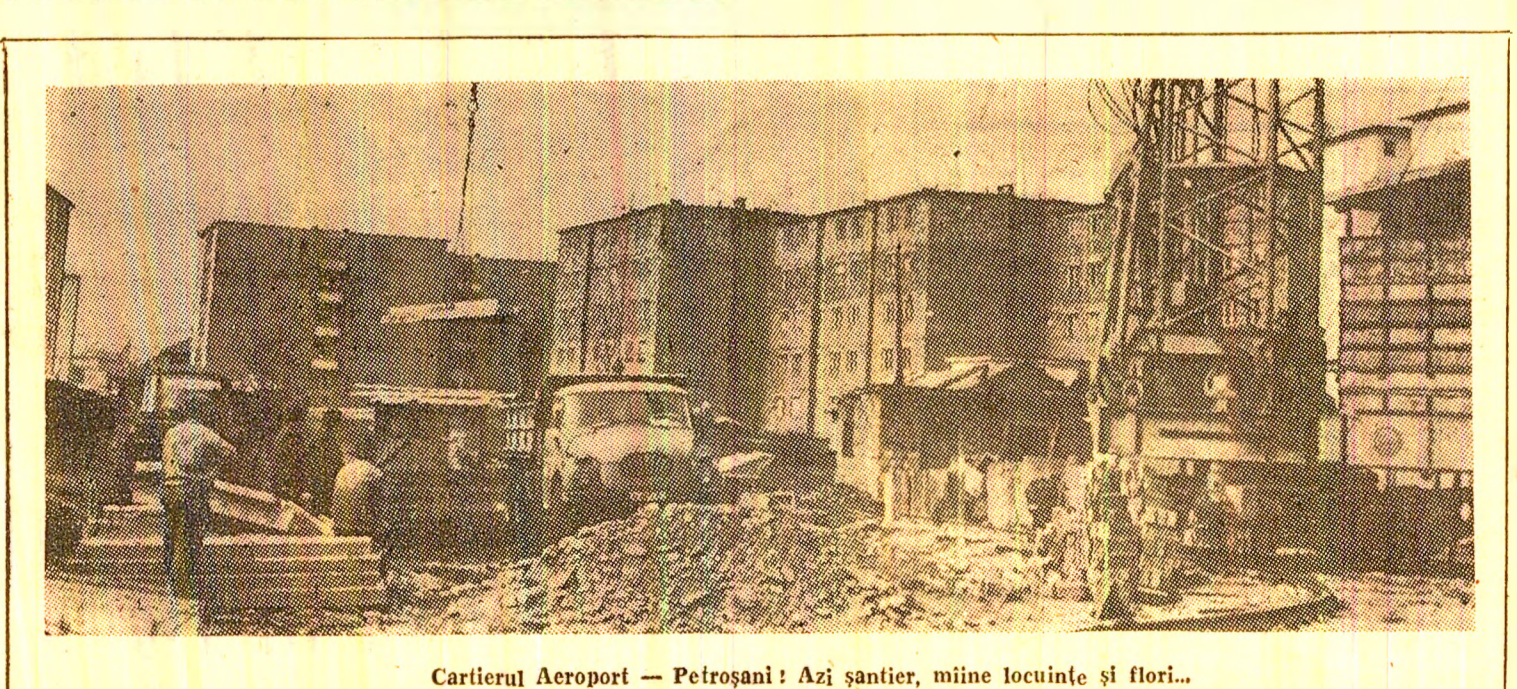
Cartierul Aeroport — Petroșani: Azi șantier, miine locuințe și flori...
