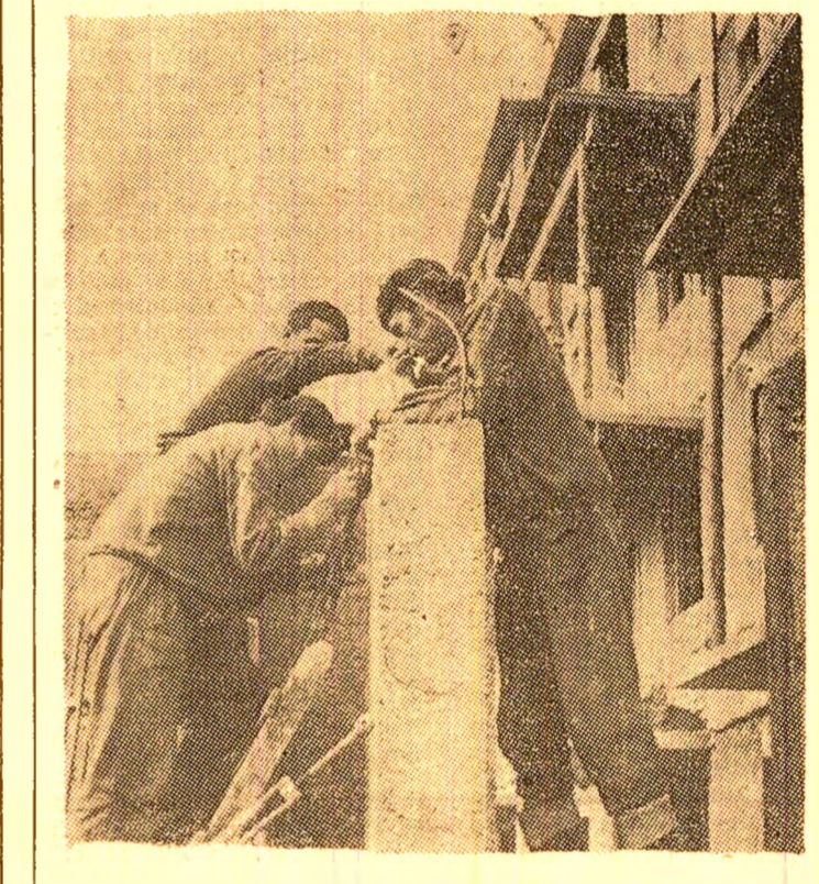
Se ridică un nou etaj la blocul E. 3-3 din cartierul Aeroport—Petroșani. În imagine, șeful de echipă Zoltan Kispał și colegii de muncă Petre Viștezu și Ilie Z. Tihăță montînd unul din panourile de prefabricate la noul bloc.
