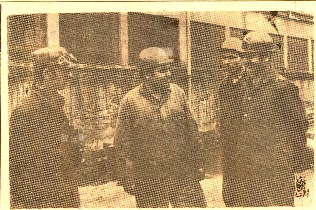
Preparația carbunelui Petrita. Șeful de echipă Liviu Chiș împreună cu lăcătușul Adalbert Matyus și sudorii Mihai Buliga și Ioan Gaida satisfacți de reparațiile executate la instalațiile din secția uscătoare, pe care le execută cu regularitate și de cea mai bună calitate. Foto: Miron HORGA
