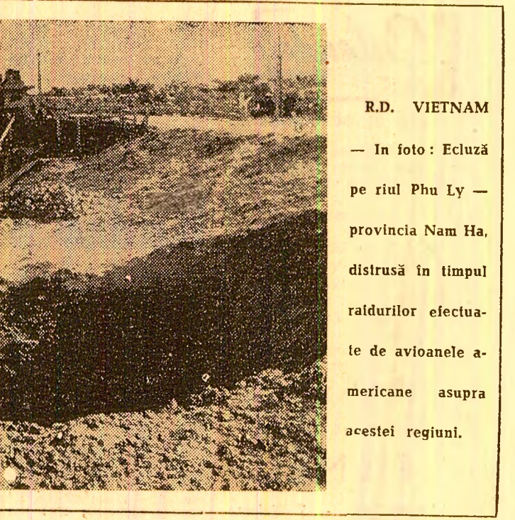
R.D. VIETNAM — In foto: Ecluză pe riul Phu Ly — provincia Nam Ha, distrusă in timpul raidurilor efectuate de avioanele americane asupra acestei regiuni.
