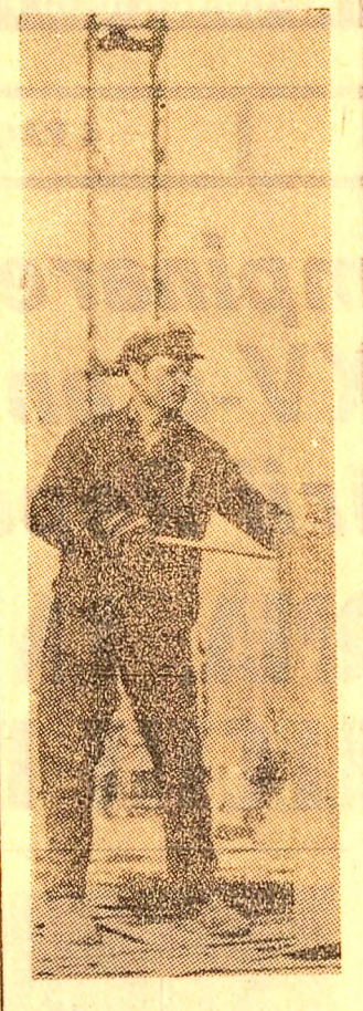
Unul din apreciații muncitori ai Poligonului de prefabricate Livezeni, om de nădejde al șantierului. Acesta este șeful echipei de dulgheri, Constantin Onu.
